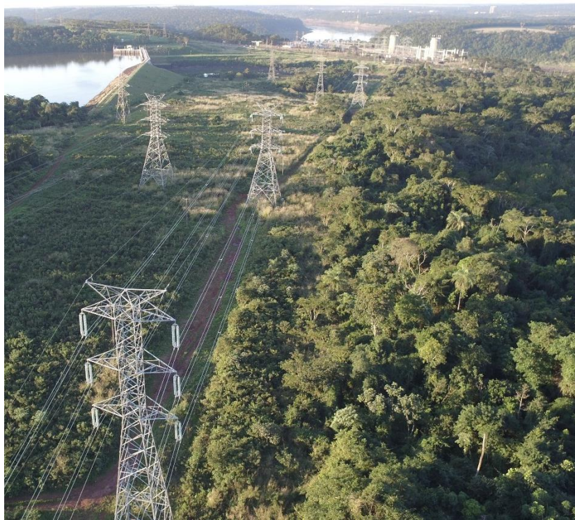
Construcción de la línea de transmisión 2 x 220 kV Acaray - Pte. Franco - Licitación Pública Nacional ANDE N° 1088/2014 - Lote 2 - BONOS II
